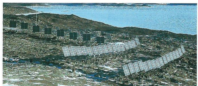
太陽光発電設備
