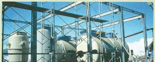
汚水処理棟（建設中の写真）
