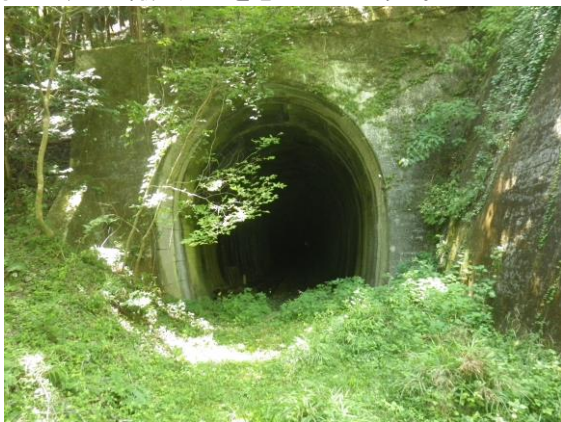
水根線 中山トンネル
