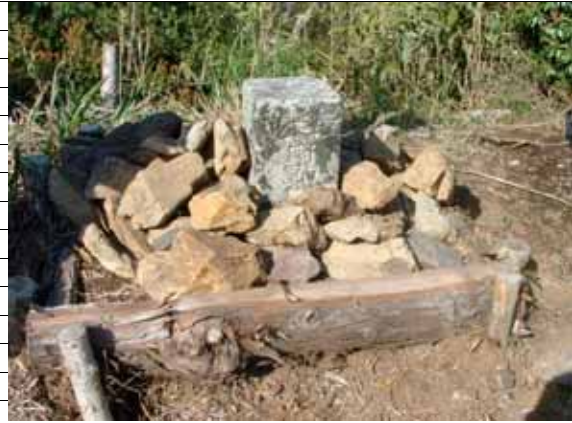
K123 三角点補強状況
