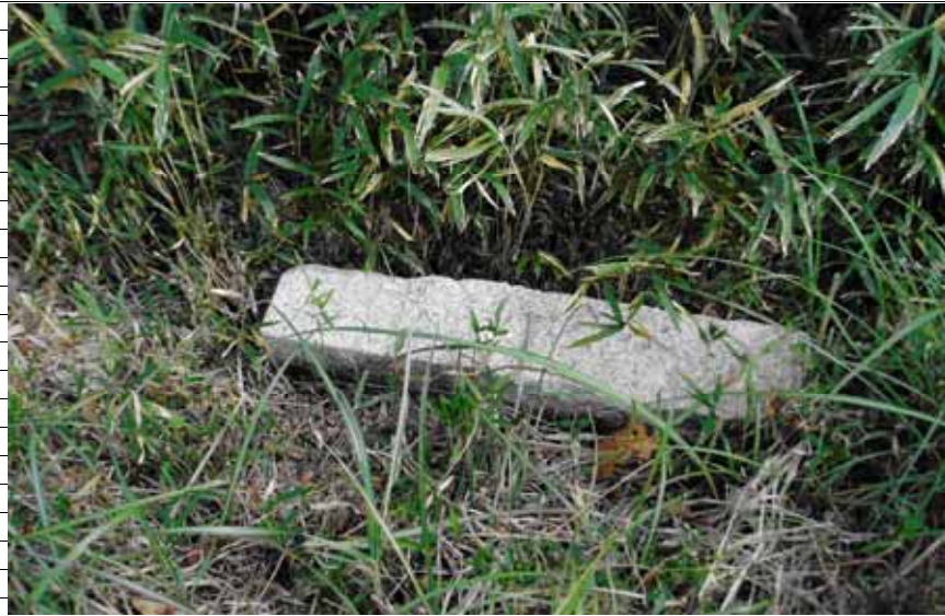
(2) 712.9m地点(K057)の倒れた三角点
