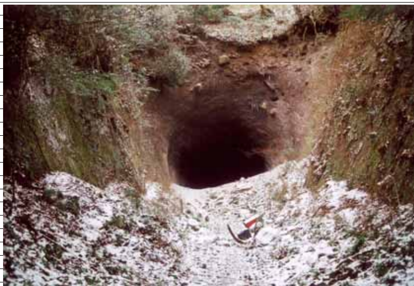
(2) 大石トンネル南側(半ば崩壊した巣堀のトンネル)
