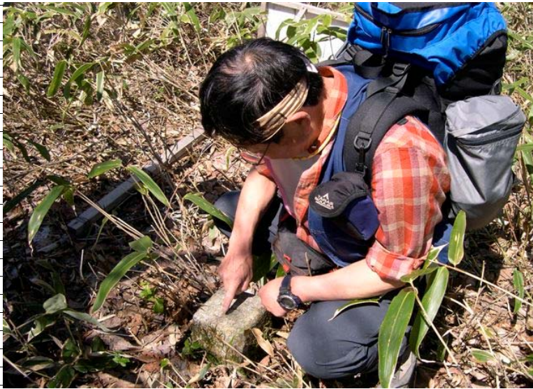
先端が欠け、根本が露出した三角点標石
